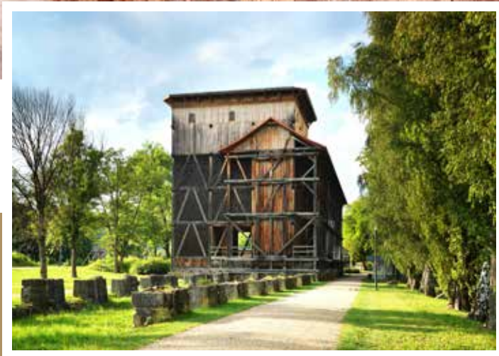
Bad Kissingen, Gradierbau
